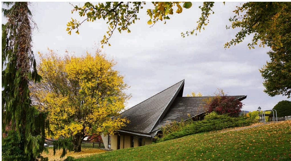
Centre paroissial de Chexbres: un lieu communautaire à rénover.
