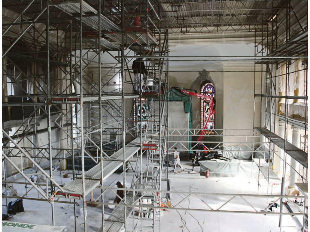
Désamianter, boucher les fissures, mettre à jour le système électrique, peindre... prier, chanter et célébrer. © Christophe Peter.
